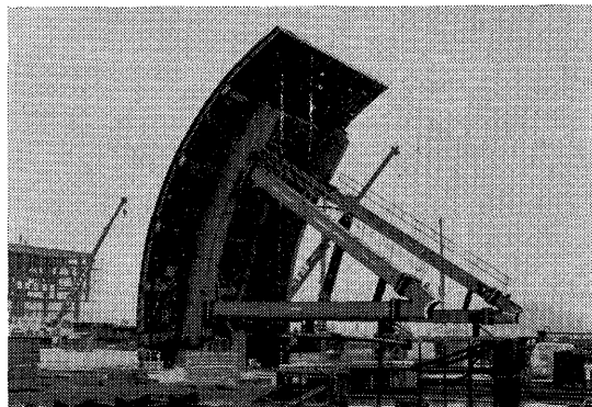
写真-1 工場仮組立 (West ゲート)
