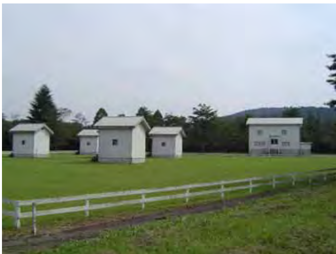
茨城県石岡市柿岡にある気象庁地磁気観測所の様子（23 参照）。各建物は非磁性の材料で建てられており、内部に磁力計のセンサーがおかれています。これらのセンサーを用いて、世界最高レベルの観測が常時行われています（気象庁地磁気観測所提供）。
