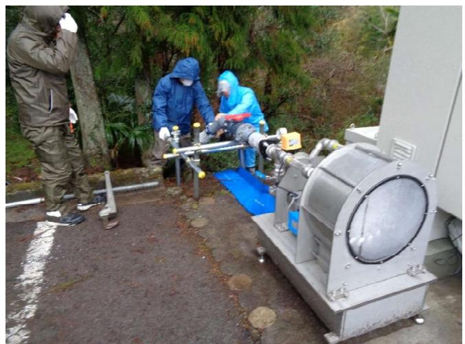
図-34 ペルトン式水車の設置状況
